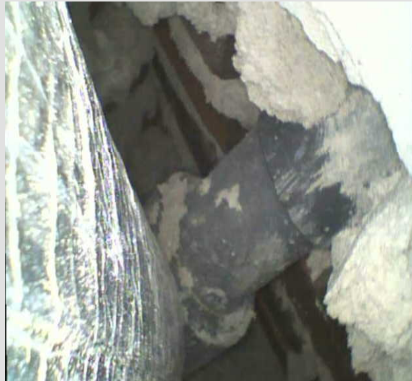
Afdichting sparing/PUR
