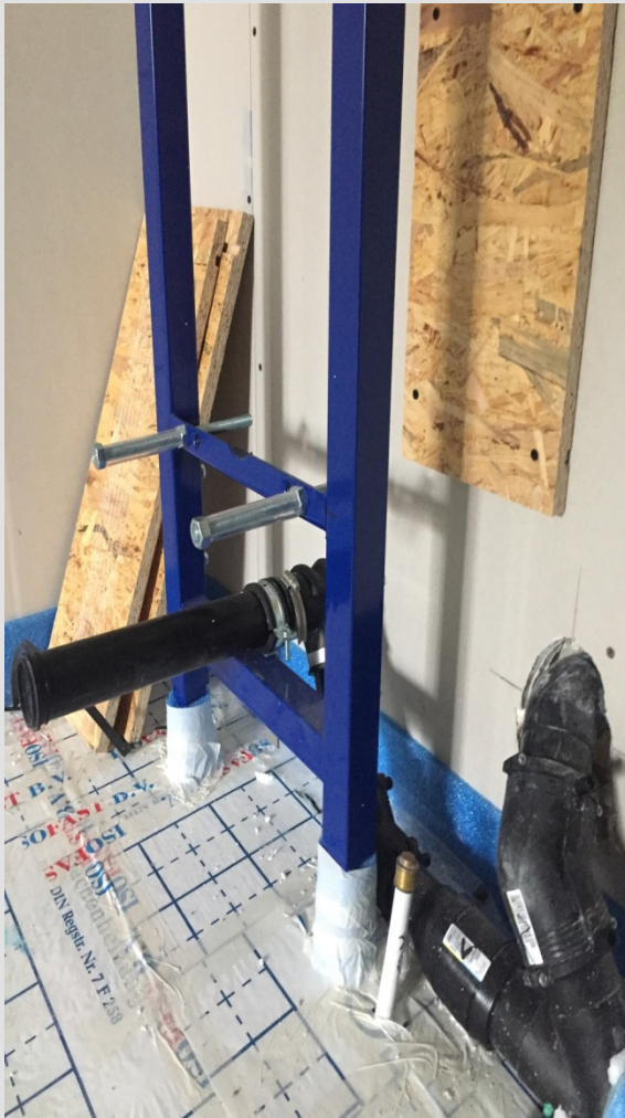
Frame toilet/isolatie zw. dekvloer
