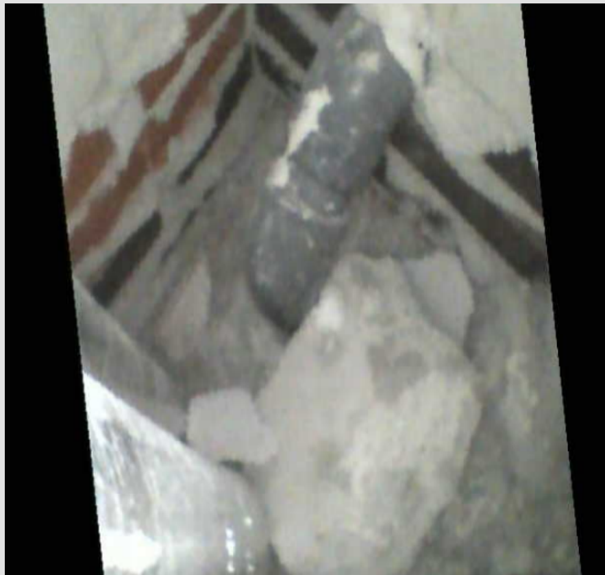
Afvoerleiding (aangestort tpv vloer)
