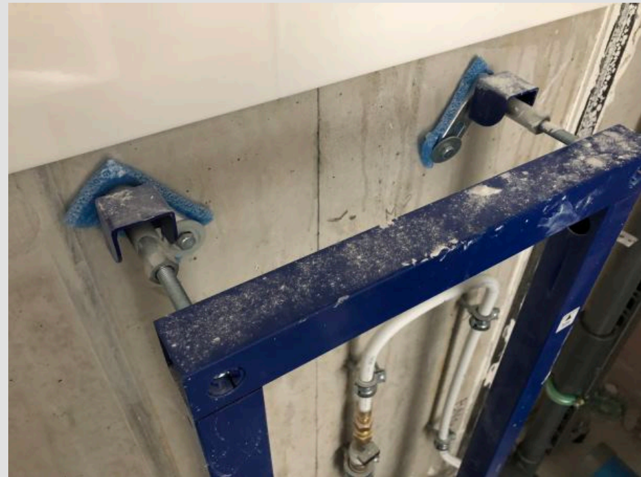
Bevestiging frame achterwand/watertoevoer (aquastop)
