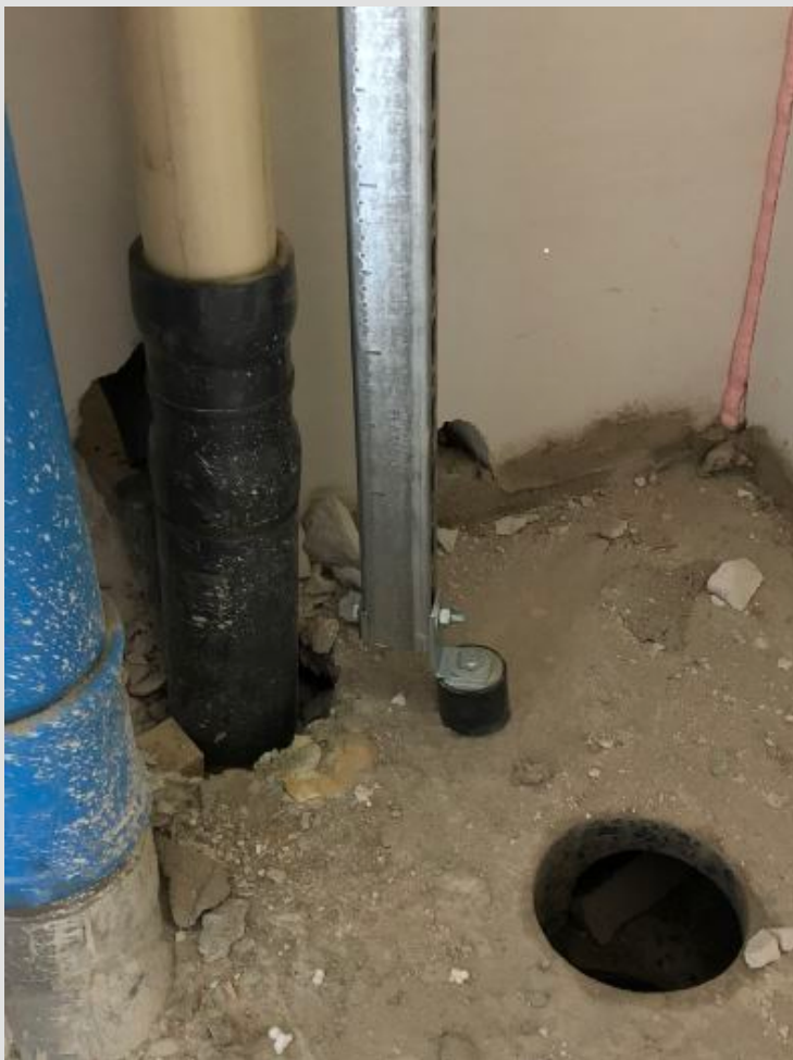
Rubber trillingdempers hulpconstructie (flamco-rail)
