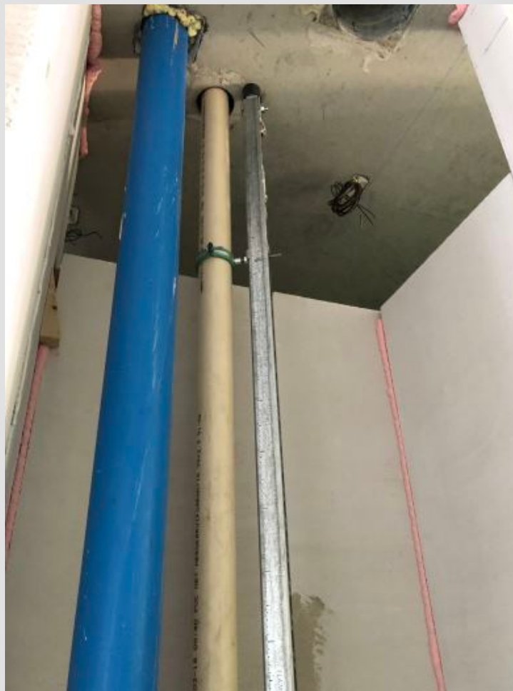
Rubber trillingdempers hulpconstructie (flamco-rail)
