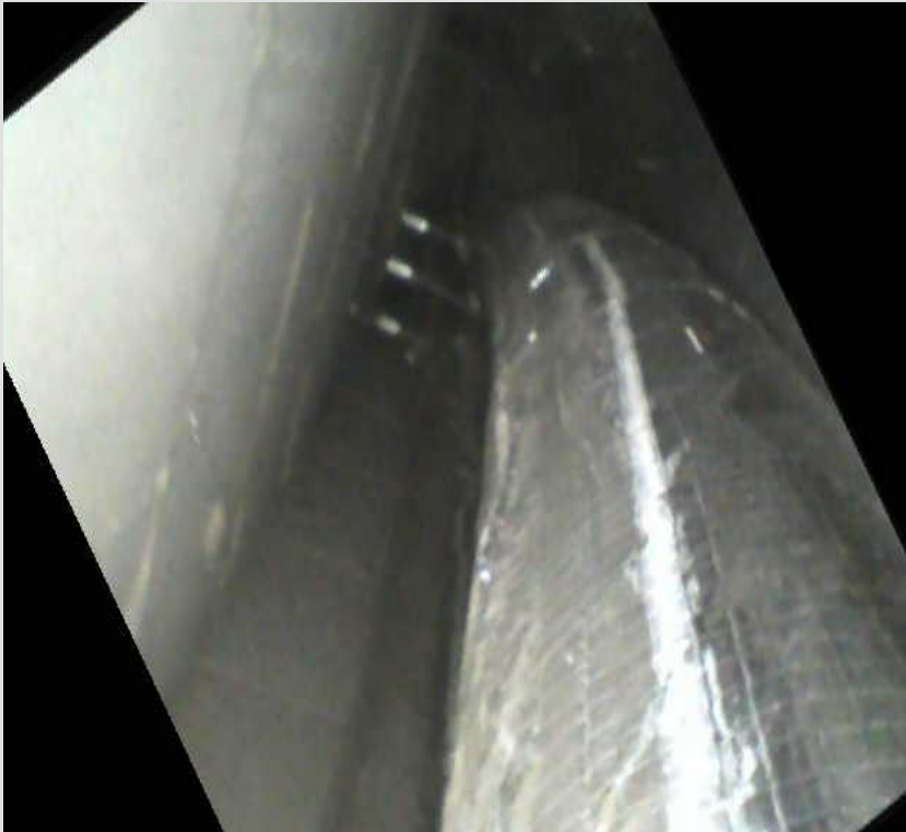
Beugeling standleiding/isolatie
