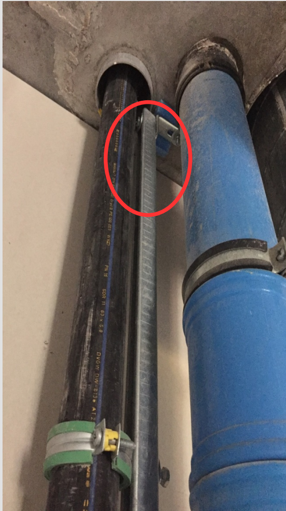
Hulpconstructie (flamcorail), schuimisolator staander
