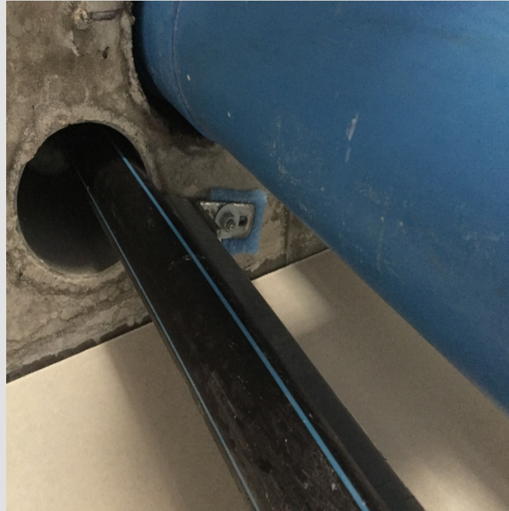
Afvoer contact met sparing
