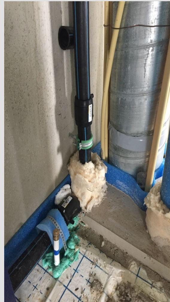
isolatie/bevestiging afvoer/wol- afdichting
